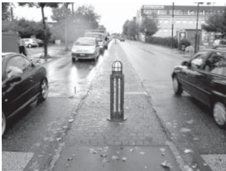
La riqualificazione di Bernstrasse a Zollikofen: la realizzazione di una fascia polivalente centrale e le corsie ciclabili laterali in carreggiata.
