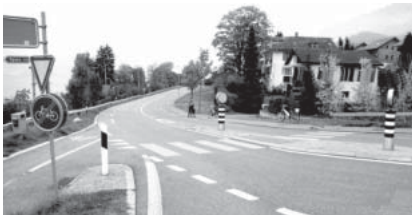
Molta attenzione è riservata alla risoluzione dei punti di conflitto: l'esempio di un incrocio tra la strada statale e il percorso ciclabile separato, con attraversamento pedonale protetto.
