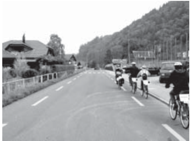
La carreggiata di un attraversamento urbano: 4.70m di corsia a doppio senso di marcia senza mezzeria e corsie ciclabili laterali.
