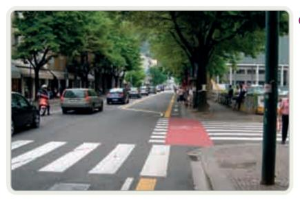
Le corsie ciclabili sono la soluzione più conveniente per la mobilità ciclabile. sono permeabili ai ciclisti e pedoni, però c'è il rischio che le auto ci parcheggino sopra e in certe situazioni non garantiscono una sufficiente protezione dal traffico veicolare soprattutto se con una importante componente di veicoli pesanti.
