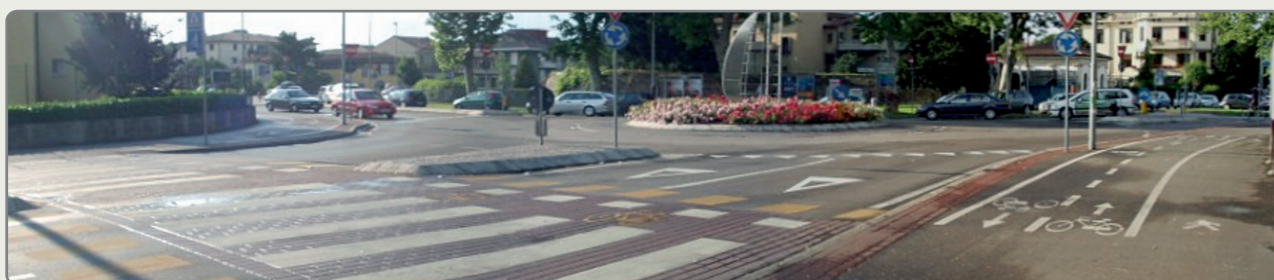
ROTATORIA COMPLETAMENTE CIRCONDATA DA PERCORSO BIDIREZIONALE - PADOVA
