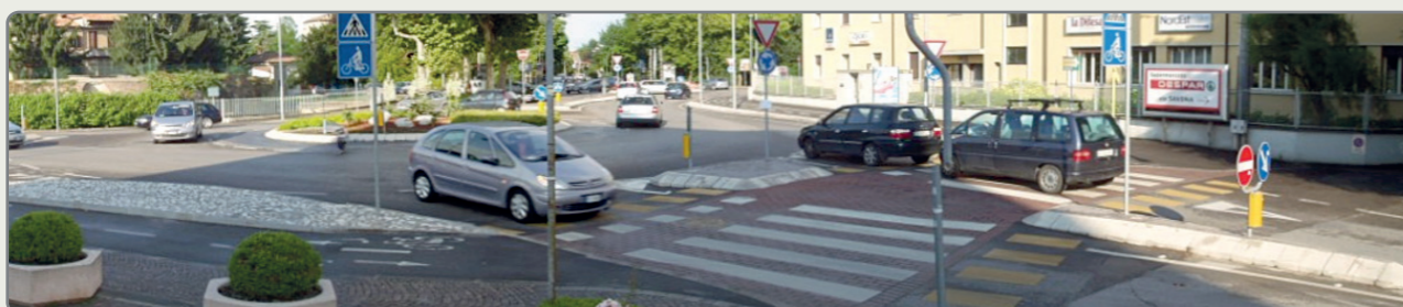
ESEMPIO DI ROTATORIE COMPLETAMENTE CIRCONDATE DA PISTA CICLABILE BIDIREZIONALE - PADOVA
