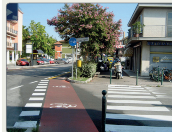
PISTA CICLABILE MONODIREZIONALE CHE DA CONTIGUA SUL MARCIAPIEDE DIVENTA CORSIA IN BORDO STRADA
