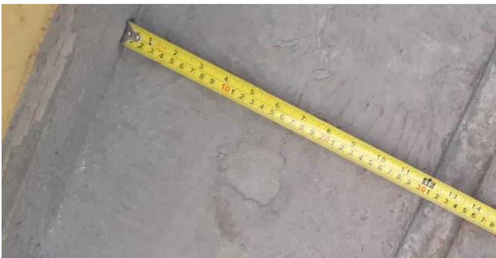
Scivolo in cemento con canalina nella stazione ferroviaria RFI di Castel Maggiore (BO). Da notare la generosa larghezza (300 mm dal battiscopa alla canalina + 50 mm di canalina) e la superficie ruvida che evita che le bici frenate scivolino se hanno le gomme bagnate (foto FIAB Bologna)
