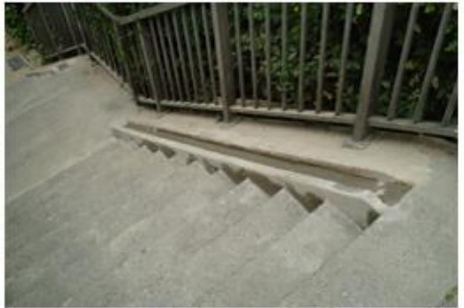
*Vari tipi di canaline e scivoli (Cycle-Works Ltd)*
